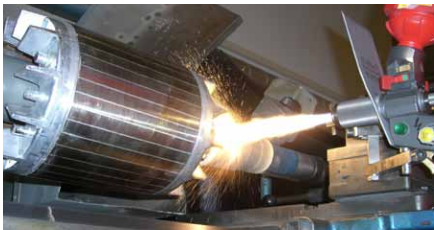
Ремонт ротора по технологии RotoTec®.
